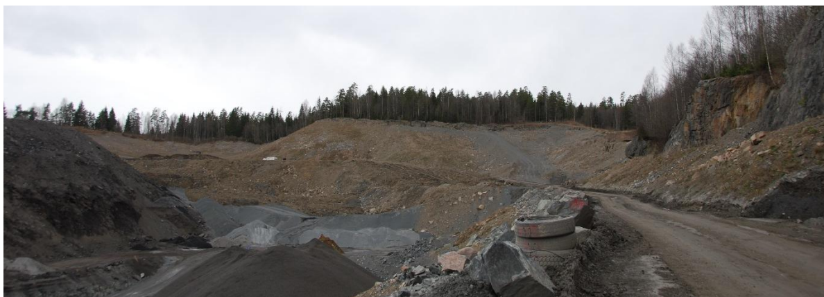
Figur 13 Nordbruddet sett i nordlig retning. Sikringsskråningene med helning 1:2 kan antydes mot skogen i nord.
