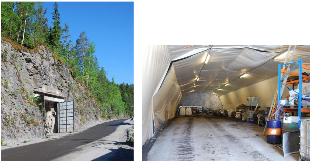
Figur 24 Bildet til venstre viser portalen inn til fjellhallen. Bildet til høyre viser det innvendige arealet med råsprengte vegger.
