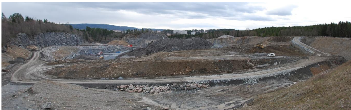
Figur 12 Bilder fra nordbruddet sett mot sør. Bildet er tatt i april 2017, og viser pågående oppfyllingsarbeider og sikring av bruddet. Massene midt i bildet er mellomlagring av masser og vil ikke bli liggende ved driftsavslutning.
